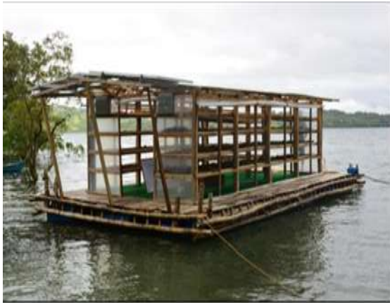
Kielelezo 28 a) Kikaushio cha mwani kwa njia ya jua kinachoelea juu ya bahari.
